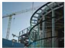
Construction & Maintenance bâtiment
